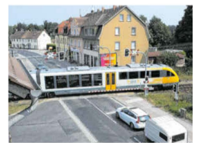
Der Bahnübergang in Rietschen wird erst nach der Sanierung der Straße nach Daubitz erneuert.
